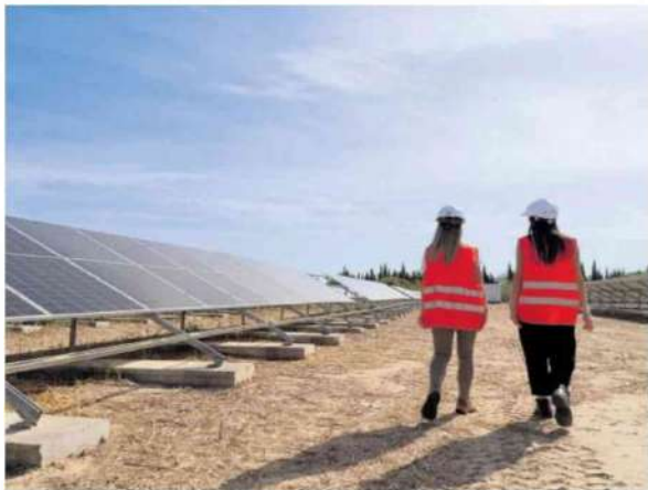
Planta solar fotovoltaica de Veolia en Córdoba. FOTOS CEDIDAS POR LA COMPAÑIA
