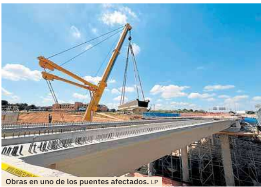
Obras en uno de los puentes afectados. LP
